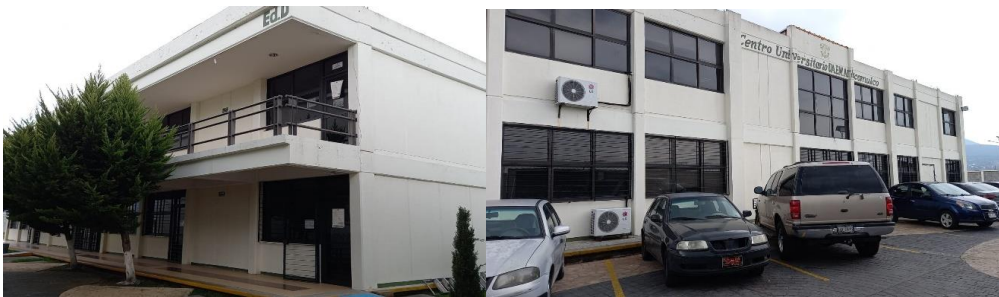
Imagen. Edificio “D”. Infraestructura académica para Ciencias de la Computación y Sociales, estacionamiento al profesorado. Centro Universitario Atlacomulco. 2023
