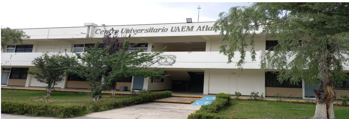
Imagen. Edificio “C”. Centro Universitario UAEM Atlacomulco. 2023
