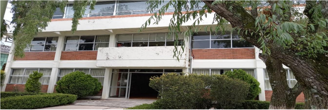
Imagen. Edificio "A". Del Centro Universitario UAEM Atlacomulco. 2023
